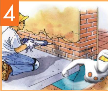
Una volta eseguiti i fori, pulire mediante soffiaggio od aspirazione dei residui. Procedere all'iniezione di **TRIPLEZERO** fino al riempimento a rifiuto del foro.
